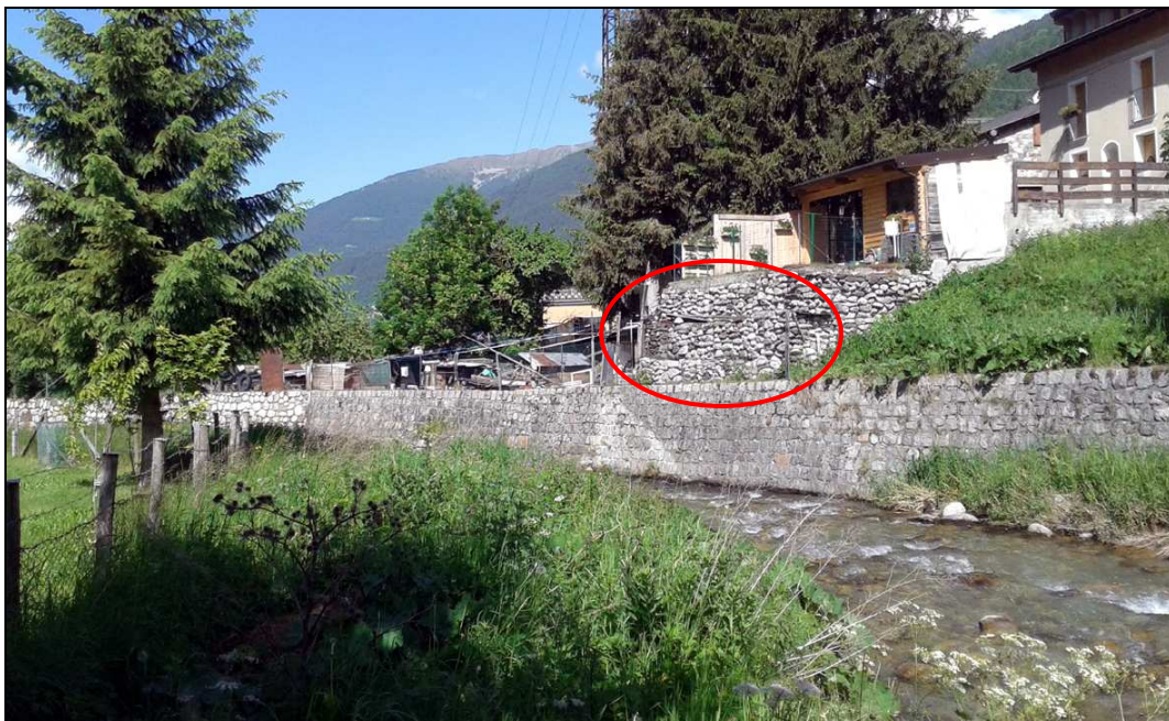
Foto 9 Il muro arginale che protegge questo tratto della sponda orografica destra del Fiume Oglio (Area G – Tavola 4A). Il tracciato della futura tubazione, che corre a monte del suddetto muro, andrà ad interferire con una gabbionata esistente (evidenziata dall’ovale rosso) che dovrà essere temporaneamente rimossa.
