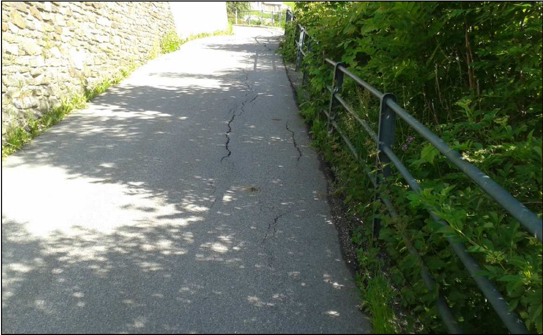
Foto 13 Le vistose deformazioni che interessano la sede viaria e le barriere di sicurezza di via Vittorio Veneto, ubicata al margine nord-orientale dell’abitato di Vione (Area L – Tavola 5A). A valle della strada è presente un corpo di frana quiescente.
