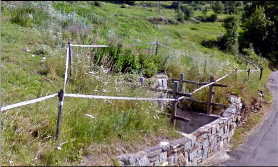
Foto 11 La caditoia ed il tombotto che permettono il sottopasso della sede stradale (via Val D'Avio) posizionati in corrispondenza del corso d'acqua più occidentale dell'Area H (Tavola 4A).
