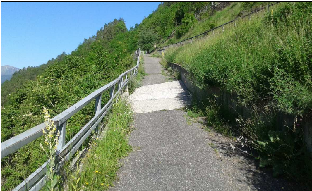
Foto 16 Il significativo cedimento della sede viaria della vecchia strada che collegava Vione con la frazione di Canè (Area M – Tavola 5A), nel tratto compreso tra il santuario e l'innesto con la nuova strada. Tale situazione di dissesto dovrà essere attentamente analizzata e sanata prima della posa delle tubazioni in progetto.
