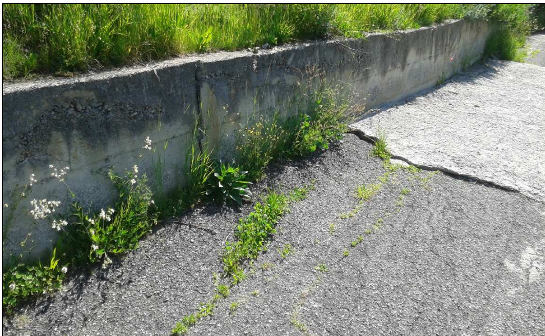
Foto 17 Un particolare del fenomeno di cedimento descritto nella Foto 16 e che mostra gli effetti dei movimenti gravitativi sulle strutture presenti in loco.
