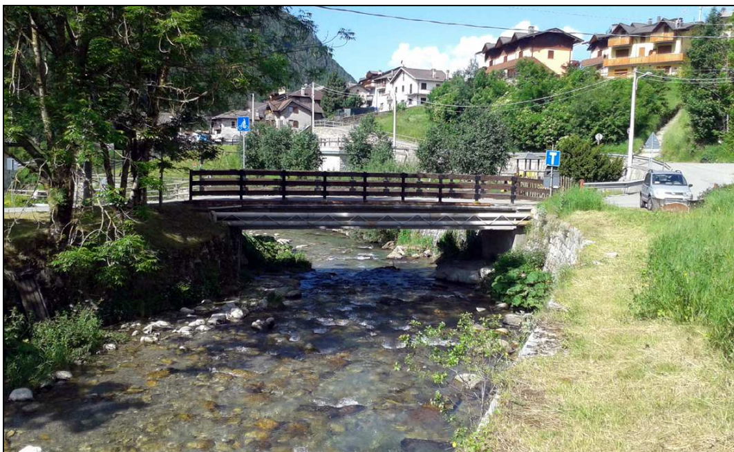
Foto 10 Il ponte ubicato in corrispondenza dell’attraversamento del Fiume Oglio (Area G – Tavola 4A). Entrambe le sponde sono protette da muri in pietrame e calcestruzzo in buono stato di conservazione.
