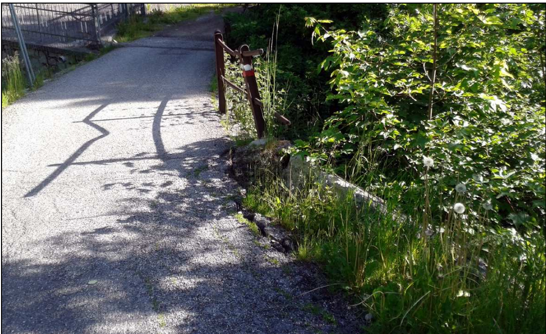
Foto 14 Il cedimento della sede stradale ubicato in prossimità dell’attraversamento di valle della via Nazionale (Area L – Tavola 5A), in sponda orografica destra del corso d’acqua.
