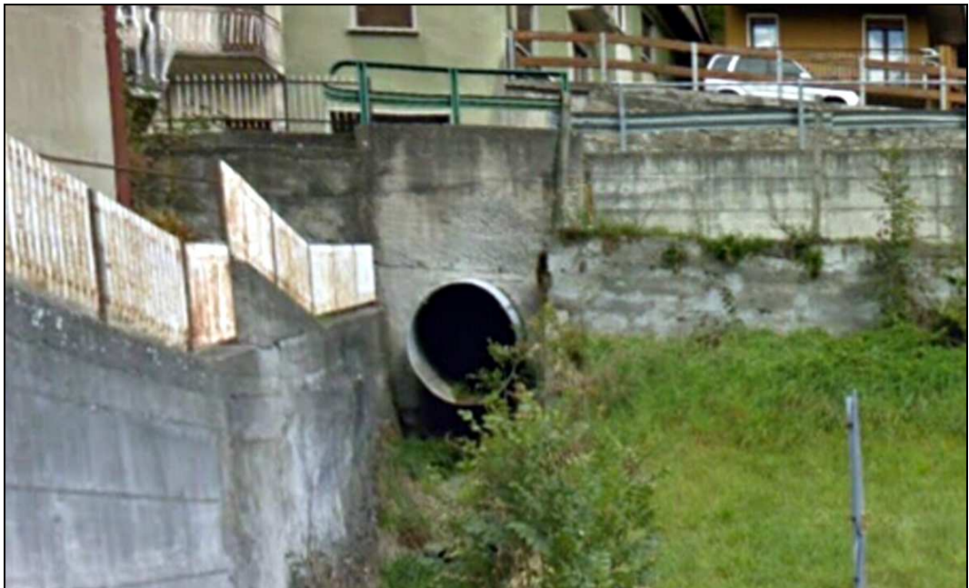
Foto 6 Il tratto intubato del corso d'acqua che sottopassa la via Dante Alighieri in corrispondenza dell'Area F1 (Tavola 4A).
