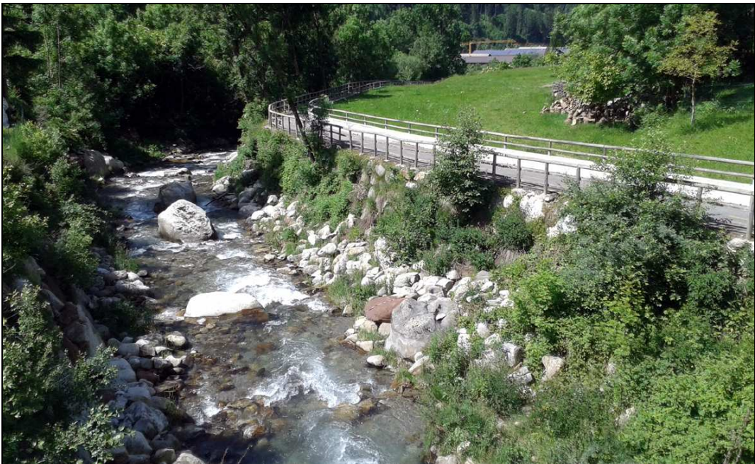
Foto 2 Muro arginale che protegge la sponda orografica destra del Fiume Oglio (Area A – Tavola 2A). La condotta in progetto correrà poco a monte della pista ciclabile che si snoda alla sommità del summenzionato muro.
